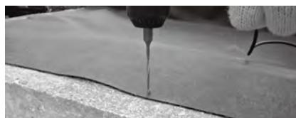
ビスの間隔は20~50cmで、シートの上からハンマードリルで下穴をあけます。直径は3.4~3.5mm、下穴の深さはねじ首下長さの+10mm程度が目安です。
