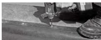
穴あけの際のコンクリートの粉を除去し、インパクトドライバーでワッシャーとともにビスをねじ込み、施工完了となります。
