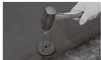
GFワッシャー®にコ型止めピン／L型止めピンをセットしておきます。ピンを打つ位置をスミ付けした後、セット済みのピンを直接ハンマーで打ち込みます。
