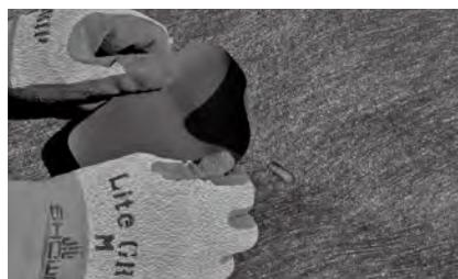
ピンを打つ位置をスミ付けした後、コ型止めピン／L型止めピンをシートに直接ハンマーで打ち込みます。仕上げにピンの上から防草パッチ®を貼ってください。
