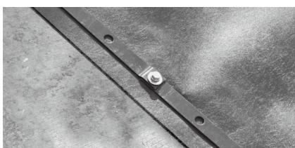
穴あけの際のコンクリートの粉を除去します。アンカーボルトとフラットバーの間にワッシャーを挟み込み、インパクトドライバーでねじ込みます。2本目のフラットバーを連結して固定し、最後に中間部を固定し、全て固定したら施工完了となります。
